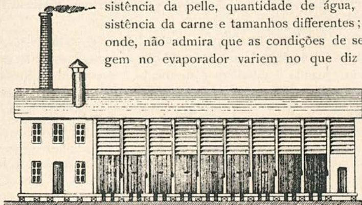
FIG. 42 — Evaporador horizontal Cozens, num grande edificio, destinado na Califórnia à seccagem das uvas.
