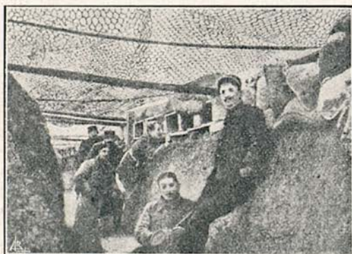
Fig. 62 — Rede metálica a defender uma trincheira contra as granadas de mão. — Cliché de Ibérica.
