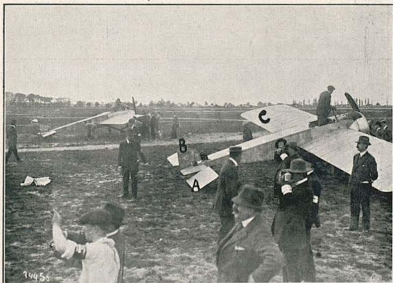
FIG. 51 — Num aerodromo. A, leme de profundura; B, leme de direcção; C, asas
