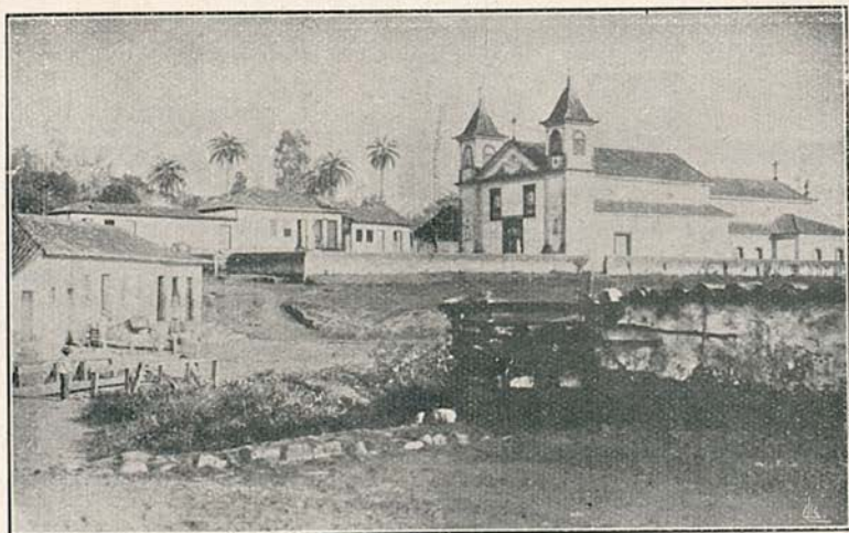
FIG. 12 — Arraial de Bello Horizonte, em Agosto de 1894. Largo da Matriz
