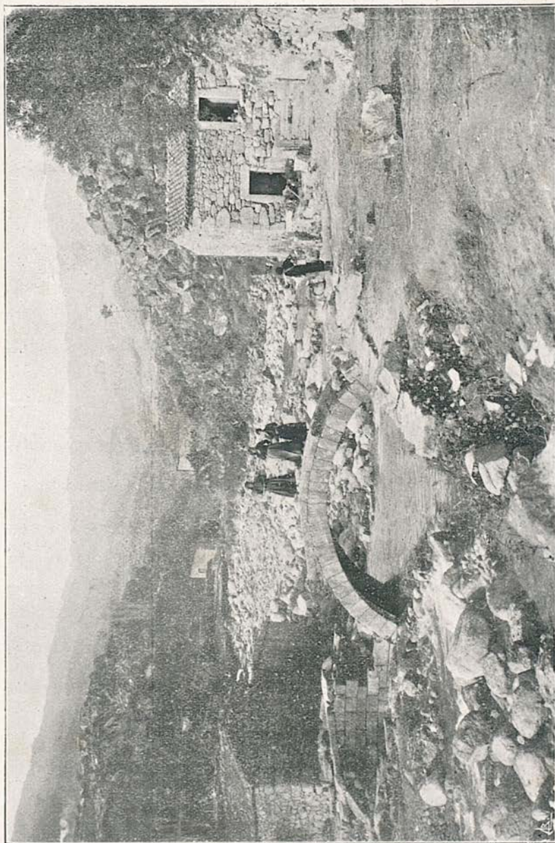
FIG. 32 — A ribeira da Alpreada, abaixo de Castello Novo, com uma azuleja de lado, partida, e uma ponte descarnada pela enchente. Acima desta havia um campo cultivado. — Cliché de J. S. Tavares.
