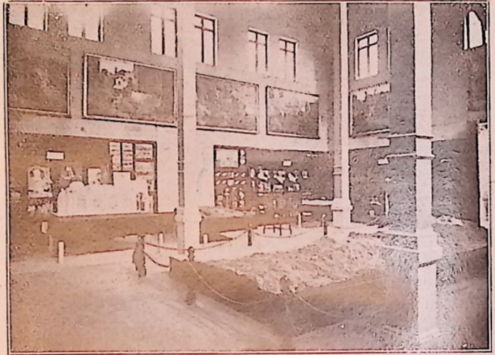
Il Padiglione « Terra Santa »
